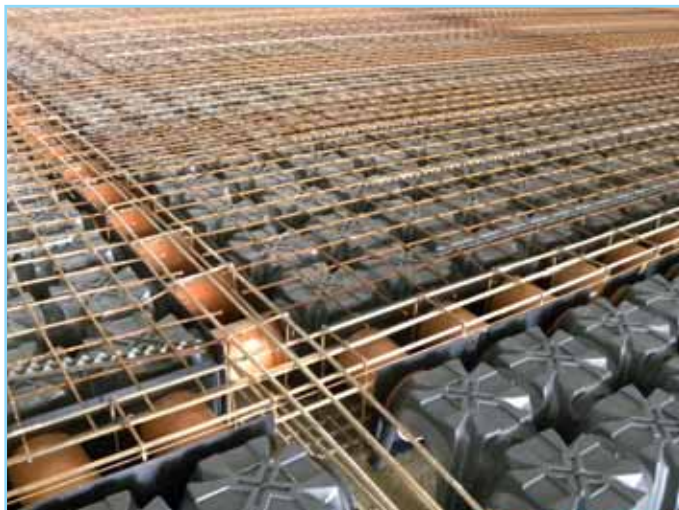
Рис. 24) г.ПАДУЯ • Холодильная камера 5970 кв.м.
