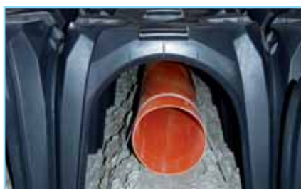
Рис. 6) Установка подземных труб.
