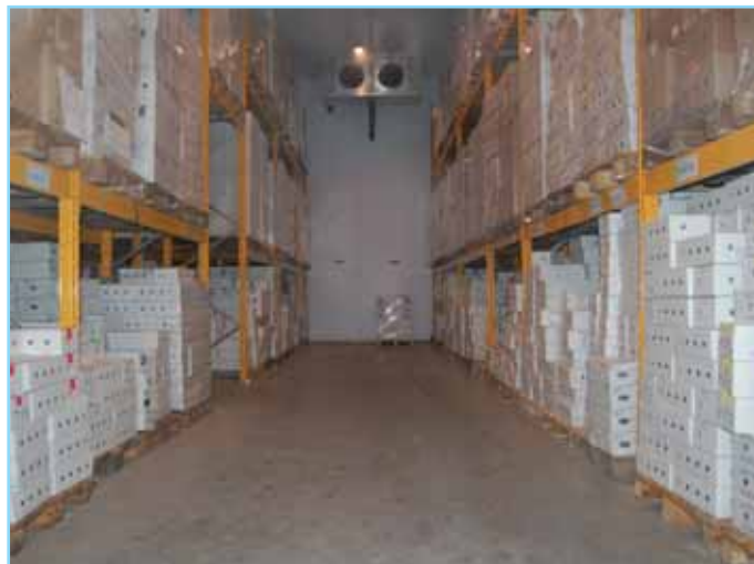
Рис. 17) г.Реджо-Эмилия • Холодильный склад 6240 кв.м.
