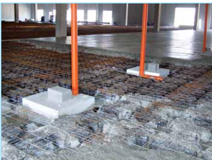
Рис. 25) г.Турин • Холодильная камера 5310 кв.м.
