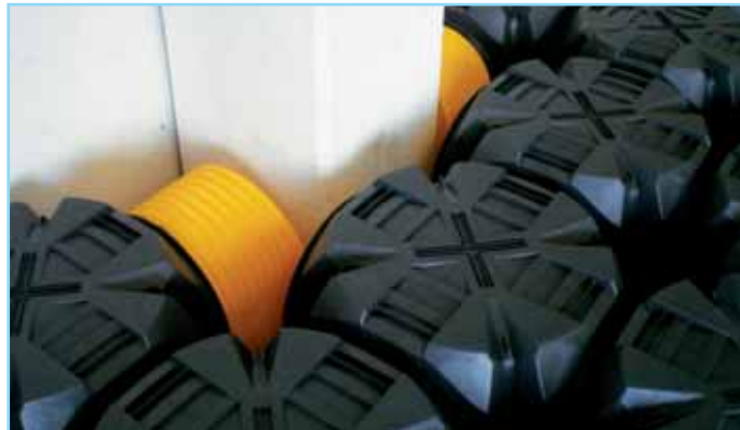
Рис. 9) Пример выравнивания вдоль колонны.
