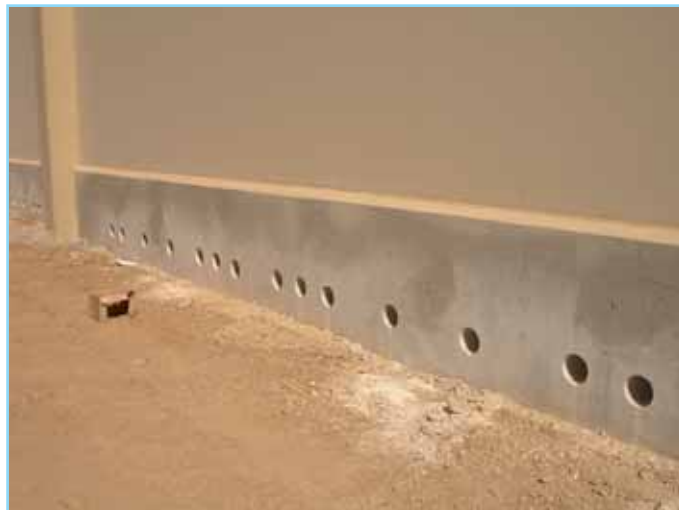
Рис. 22) г.Дзялошин – Польша • Холодильный склад 5450 кв.м.
