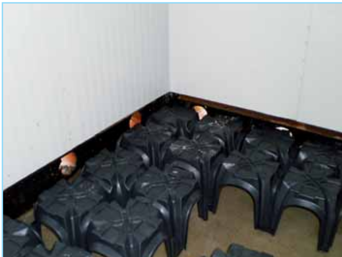
Рис. 21) г.Дзялошин – Польша • Холодильный склад 5450 кв.м.
