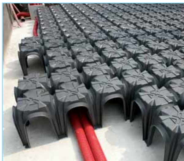
Рис. 4) Установка системы MODULO FREEZE.
