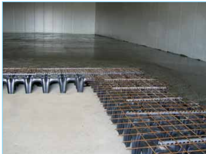
Рис. 15) г.ПАДУЯ • Холодильная камера 5320 кв.м.
